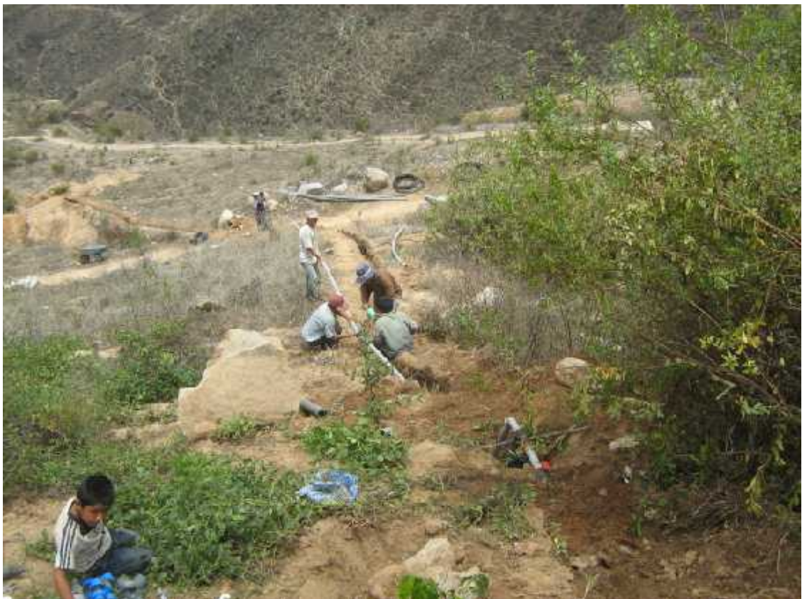
Foto 2. Instalación del sistema de riego
